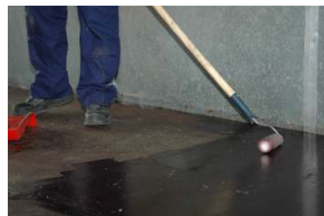
4. Vorbehandeln der Fläche mit Haftgrundierer.
