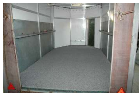
8. Nach ca. 24 - 48 Stunden ist die Fläche einsatzbereit
