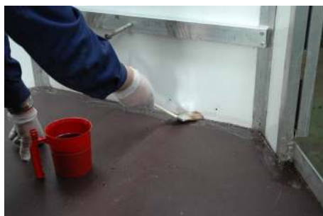
3. Vorbehandeln der Anschlüsse mit Haftgrundier 1103
