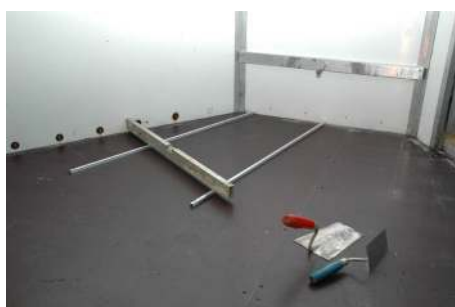
5. Hilfsmaterialien: Leisten, Glättkellen, Wasserwaage
