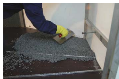
6. Aufbringen einer Mischungseinheit von ca. 6 kg
