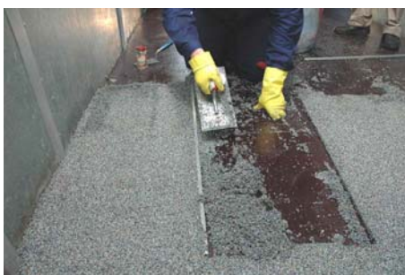
7. Schrittweises Arbeiten zum Ausgang ...
