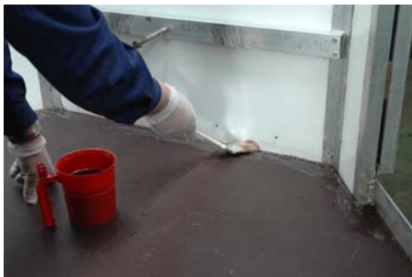
3. Vorbehandeln der Anschlüsse mit Haftgrundier 1103
