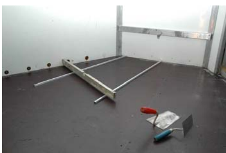
5. Hilfsmaterialien: Leisten, Glättkellen, Wasserwaage
